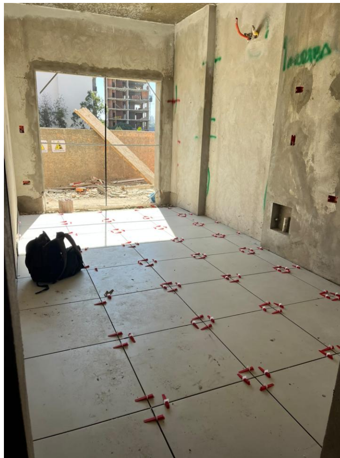
Colocación de pisos
