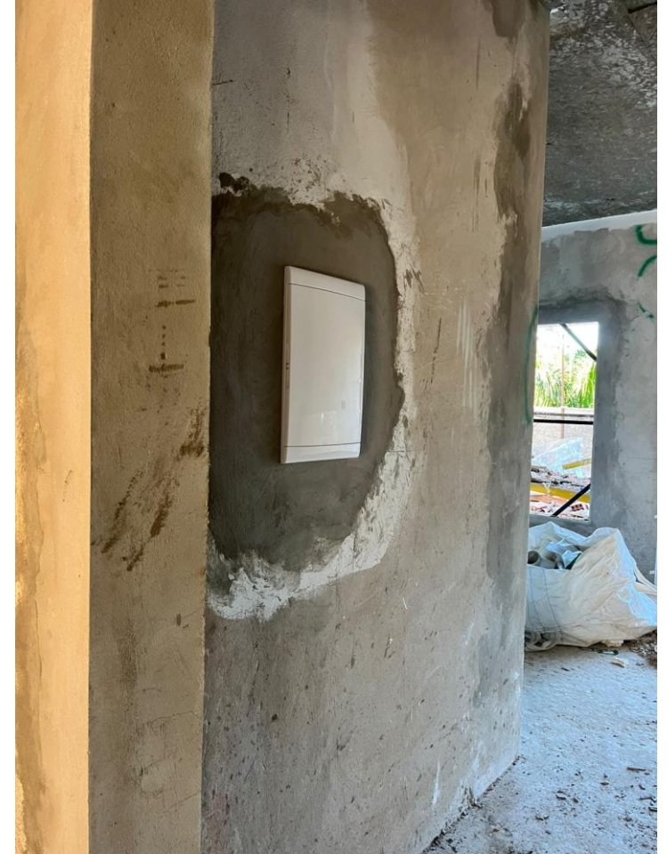
Colocación de premarcos de aberturas – Colocación/prueba de Tablero Seccional
