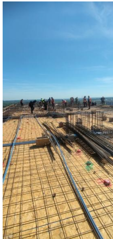
Armadura y encofrado de losa N14 – Cargamento de escalera tramo N12-N13
