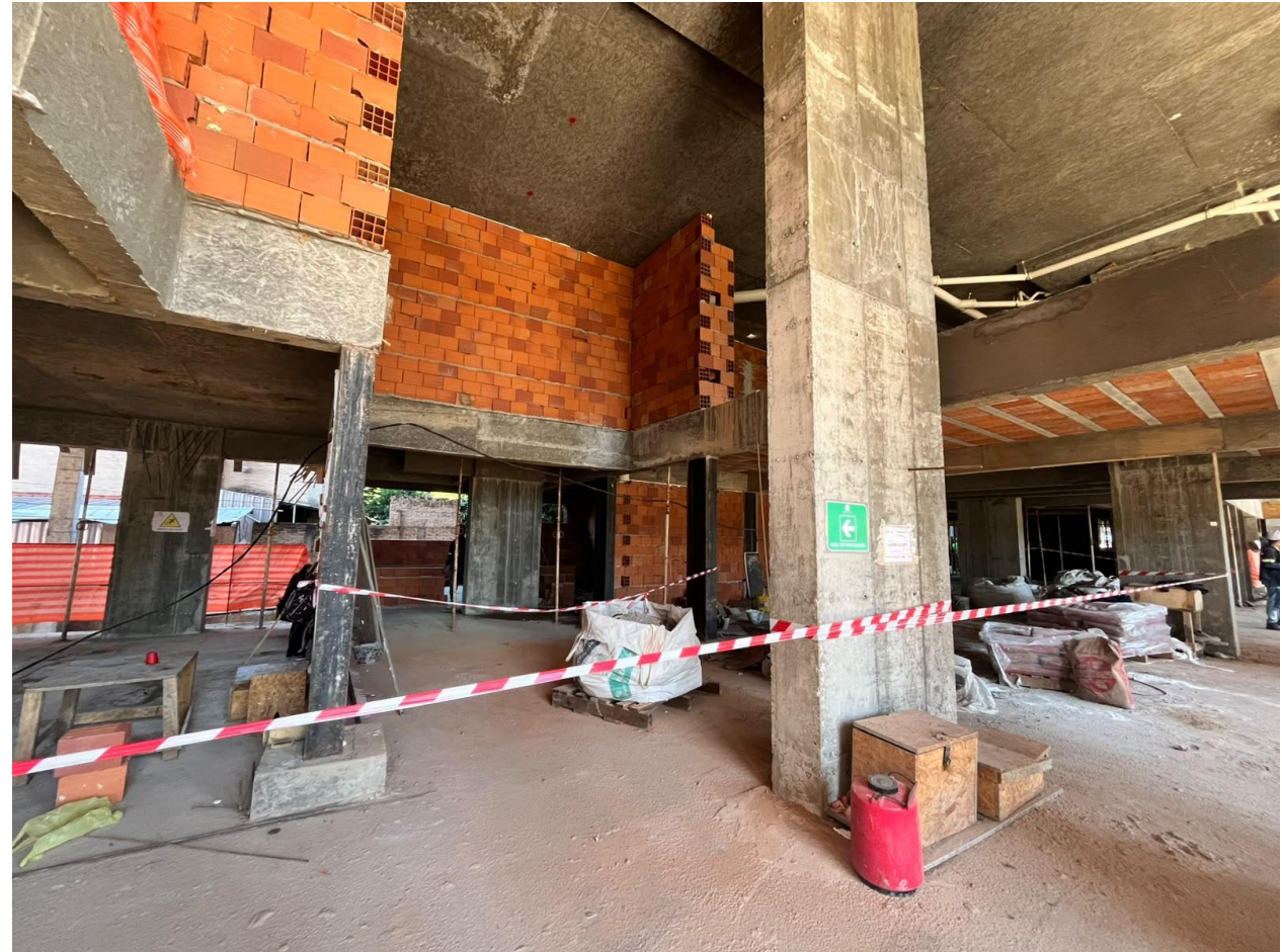
Avance de mampostería en Planta Baja y Entrepiso
