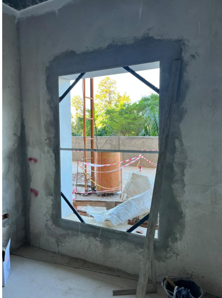
Colocación de premarcos de aberturas – Colocación/prueba de Tablero Seccional
