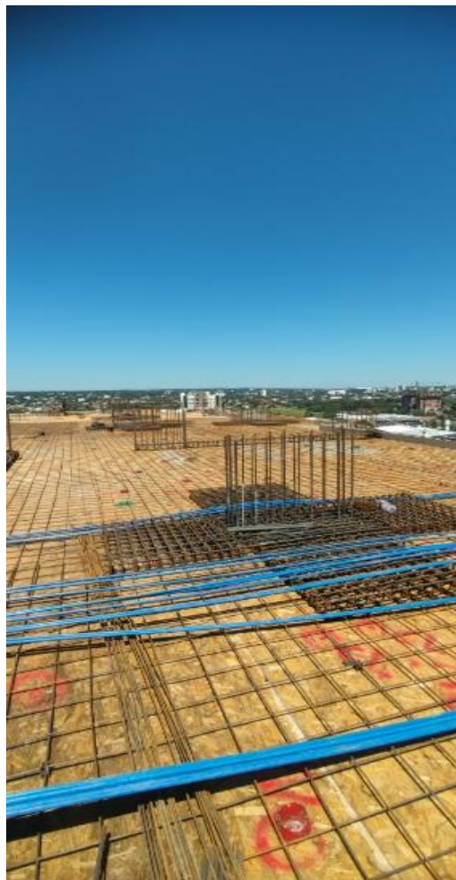
Armadura y encofrado de losa N14 – Cargamento de escalera tramo N12-N13
